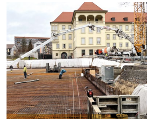
Im Februar konnte die Bodenplatte gegossen werden, im April sollen dann die Fertigmodule angeliefert werden.
