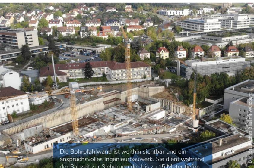
Die Bohrpfehlwand ist weithin sichtbar und ein anspruchsvolles Ingenieurbauwerk. Sie dient während der Bauzeit zur Sicherung der bis zu 15 Meter tiefen Baugrube. Später wird sie den Erddruck aus dem westlichen Hang dauerhaft vom Klinikgebäude fernhalten.
