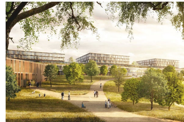
Im Siegerentwurf ist der geplante Neubau in einen Sockel und drei aufgesetzte, U-förmige Bettenpavillons gegliedert. Ansonsten sind großzügige Grünflächen vorgesehen.
