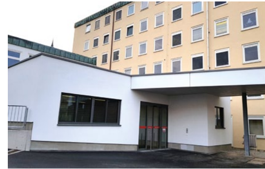
Die neue Notaufnahme liegt unmittelbar vor dem bestehenden Gebäude der Kinderklinik D31.
