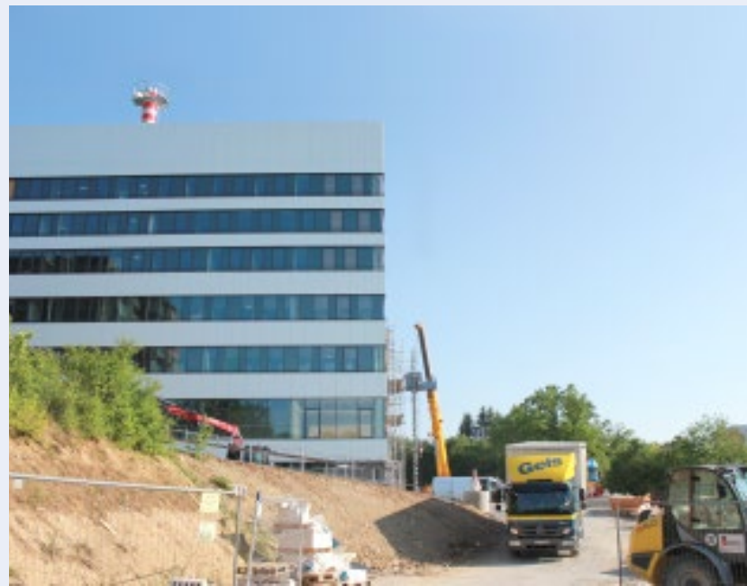
Das Deutsche Zentrum für Herzinsuffizienz soll noch im Lauf des Jahres 2016 fertiggestellt werden. Die Aufnahme zeigt den Stand Anfang Juni 2016.
