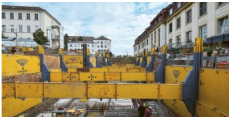
Sanierung der Versorgungskanäle.
