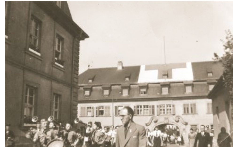
Rot-Kreuz-Zeichen auf den Dächern kennzeichneten Lazarette. Privatfoto.
