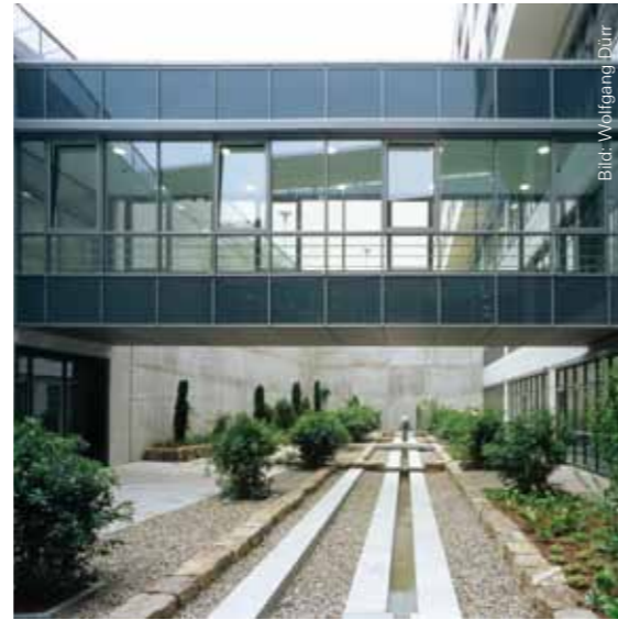
Das aus dem Oberhang austretende Schichtwasser wird gesammelt und strömt als kleiner Bachlauf durch den Löwenhof, einen der Lichthöfe des ZOM|ZIM.
